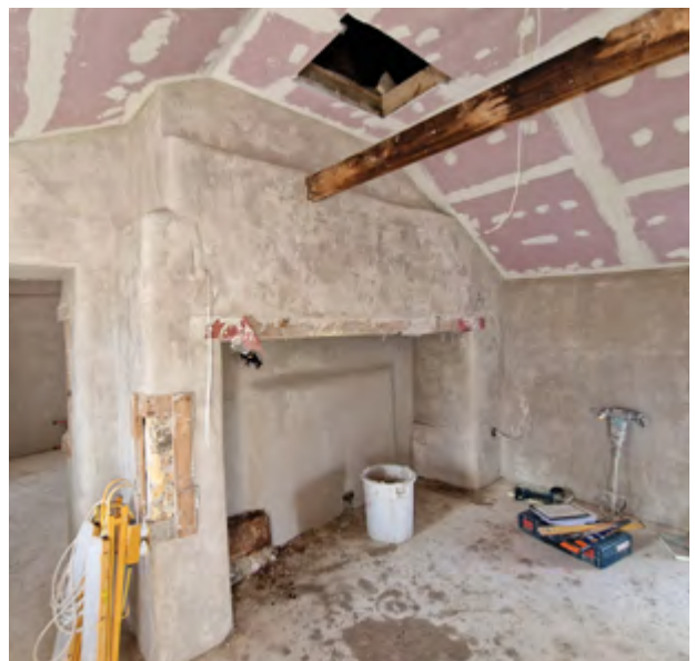
Taobh istigh de Theachín Goggin. Rindreáil aoil ar siúl - gan líne dhíreach le feiceáil! Tabhair an limistéar faoi deara in aice leis an simléar áit a ndearnadh na chéad chisil rindreála aoil a bhí ann a fhágáil nochta.
